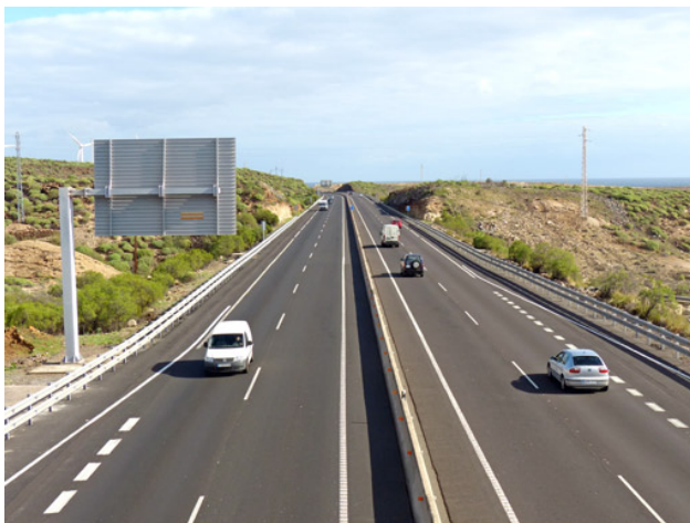
横断の陸橋から
